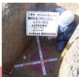
拡径部杭径確認
