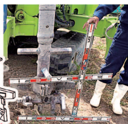
施工設備 / ビット検尺
